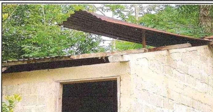
Foto 2: Aula Antigua: cambio de techo, mejoramiento de piso, repellos, cambio de puertas y ventanas
